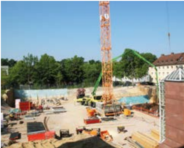
Bauarbeiten für den Erweiterungsbau
