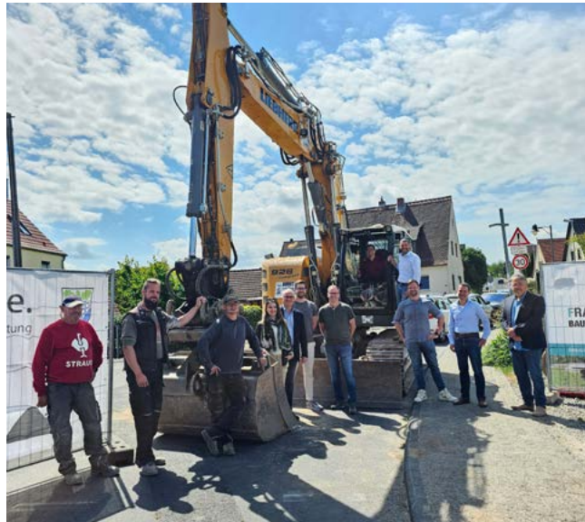
Spatenstich für den Bauabschnitt III der Ortsdurchfahrt Daxberg
